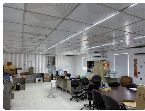
工地辦公室LED燈
